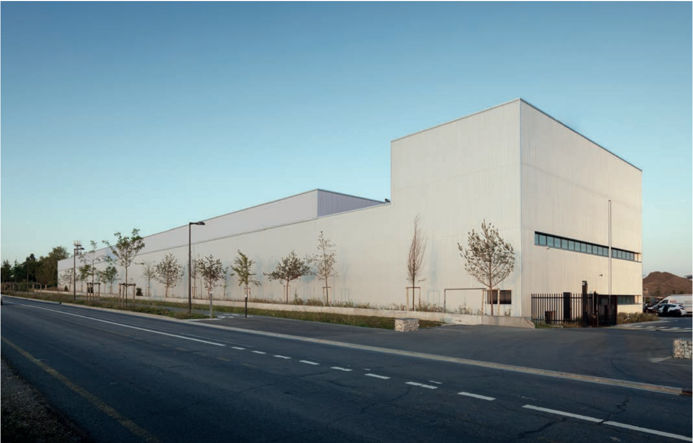
Entrepôt et ateliers des Maçons Parisiens depuis l’avenue du Maréchal-Juin, le bâtiment est intégralement revêtu d’aluminium anodisé argent.
