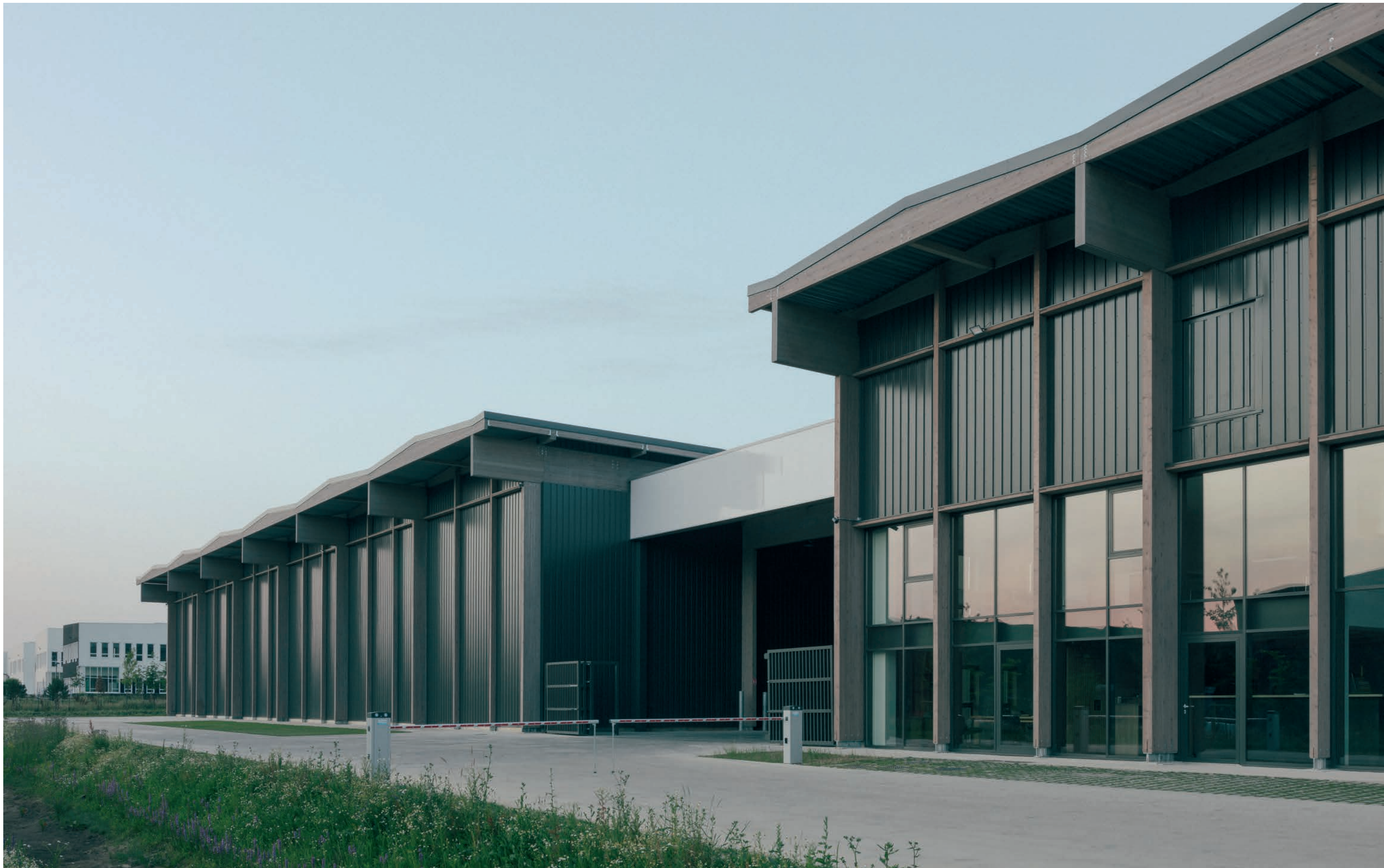
L'uniformité du lieu tient par la récurrence des formes et des matériaux. L'alternance de murs-rideaux vitrés, de portiques en bois et double peau métallique apportent à la façade de la régularité.
