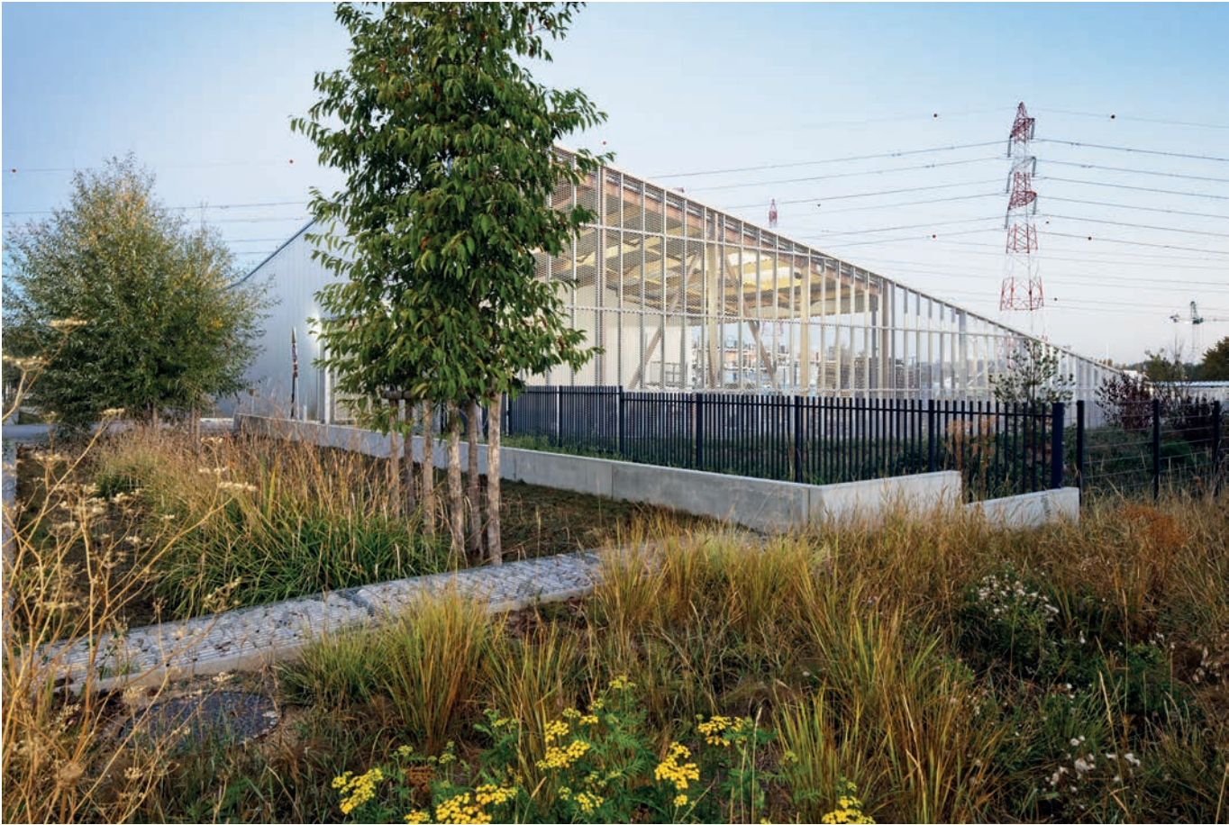
La façade joue avec la transparence ce qui permet d'entrapercevoir la cour de stockage.
