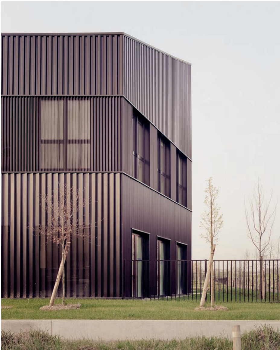
L'alternance de bardages métalliques ondulés aux motifs plus ou moins resserrés habille la façade.
