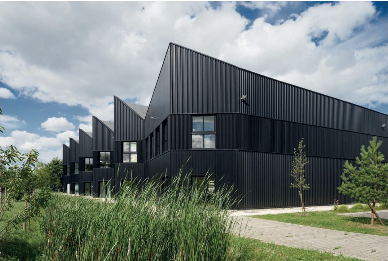
La toiture en double pente asymétrique fait directement référence aux sheds du XIX e .
