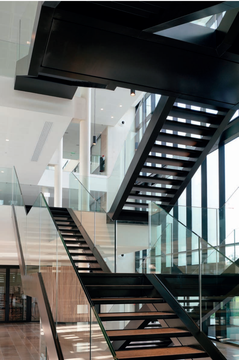
Escalier à double volées croisées des espaces de bureaux.
