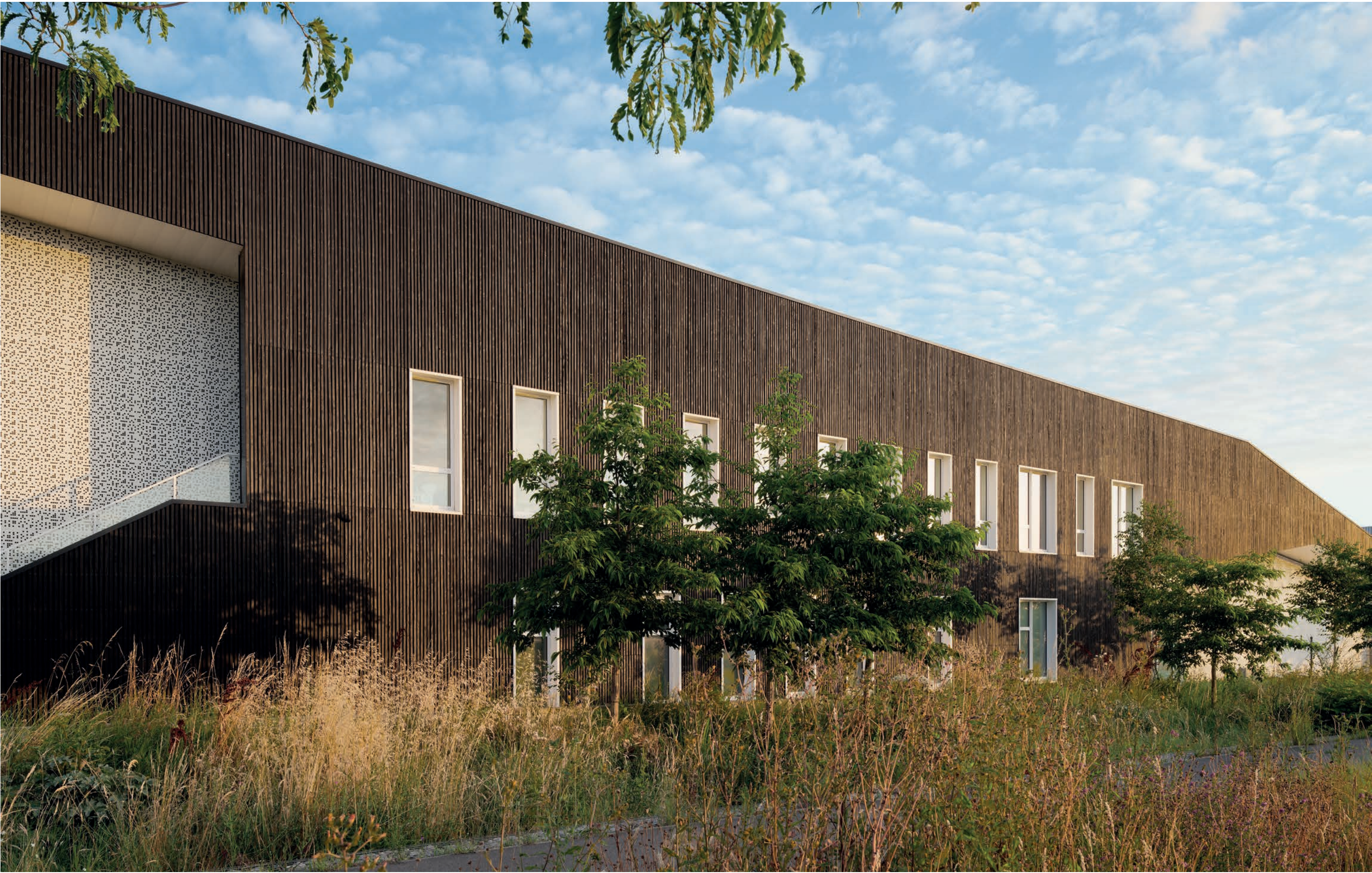
L'alternance entre bois brûlé lasuré et bardage métallique blanc et nervuré, crée un jeu de contrastes et rythme la façade.
