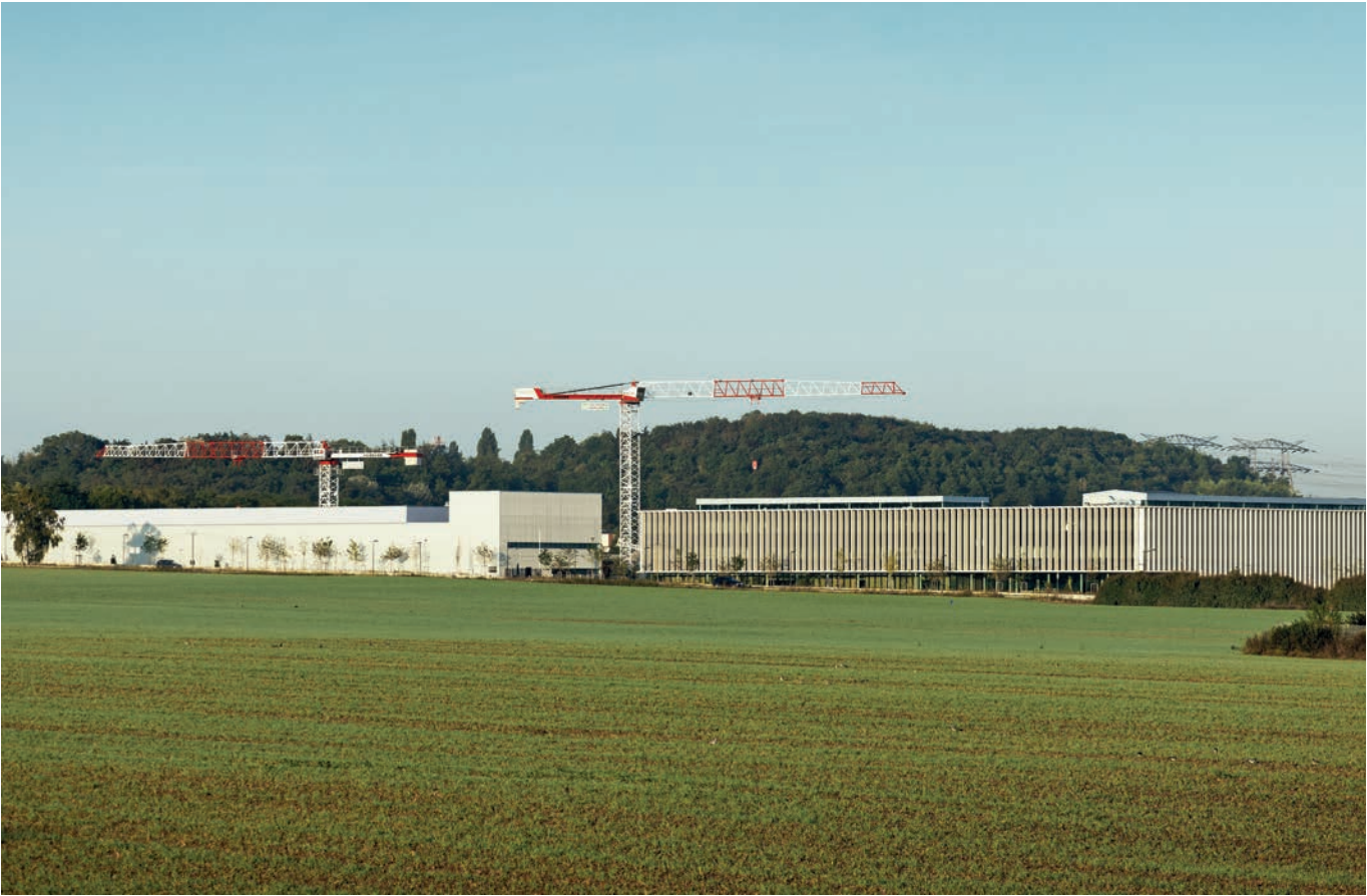
Vue sur les bâtiments des Maçons Parisiens et les grues, installées dans l'aire de stockage et de livraison.
